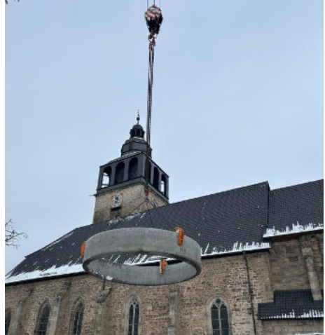
Ein spezieller Kran bringt die schwersten Teile zur dafür vorgesehenen Stelle
