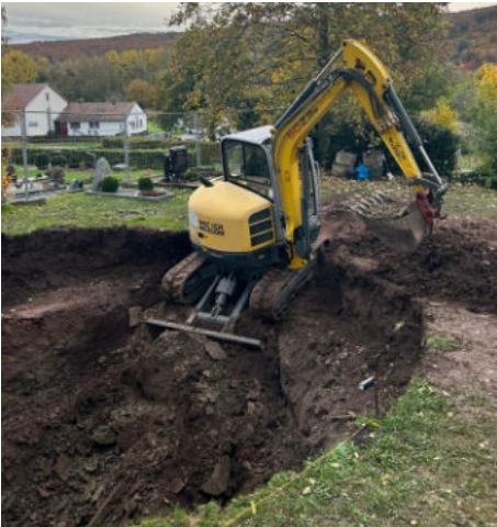
Der Brunnen wird tief in den Erdboden hinein reichen
