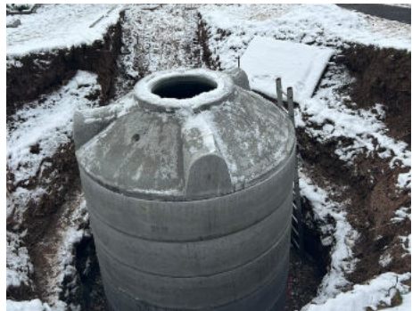
Der Rohbau wird später wie ein echter Brunnen ausschaun
